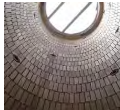
耐酸煉瓦ライニング（缶体内部）
