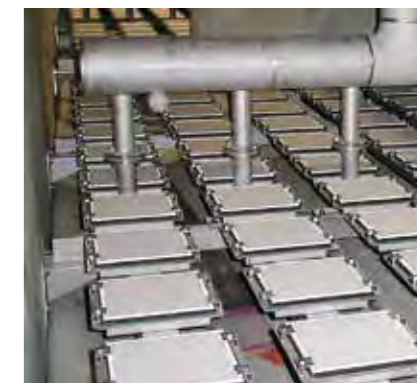
下水処理施設生物反応タンクの内部
