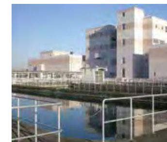
高度浄水処理施設
